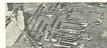
Værkstedssamlede dele til én lejligheds varmeinstallation.
